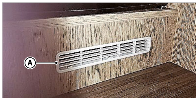
Fig.6.1 - Aberturas de ventilação permanentes
