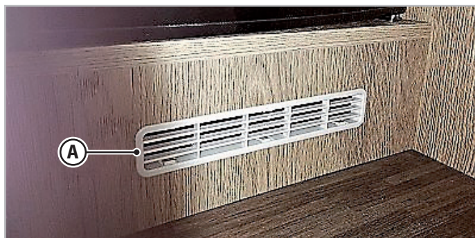
Fig.6.1 - Aberturas de ventilación permanentes
