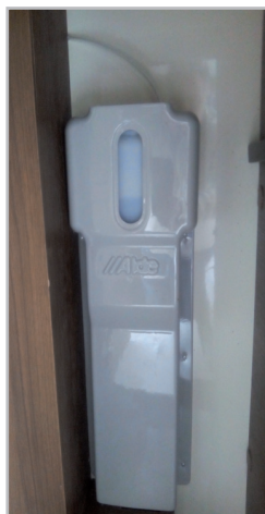
Fig.6.41 - Nivel de mezcla de glicol
